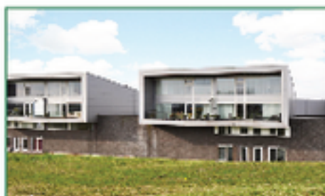
Hoek van Holland , Zekkenstraat 6, Bedrijfshal met woning uitzicht op de Nieuwe Waterweg! Vrpr. € 439.000 k.k.
