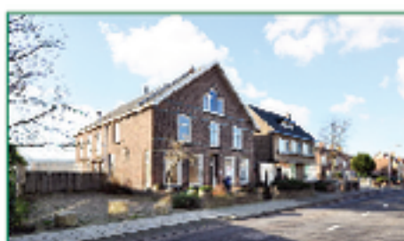
's-Gravenzande, Naaldwijkseweg 169, Renovatie of nieuw te bouwen. Vraagprijs €595.000 k.k.
