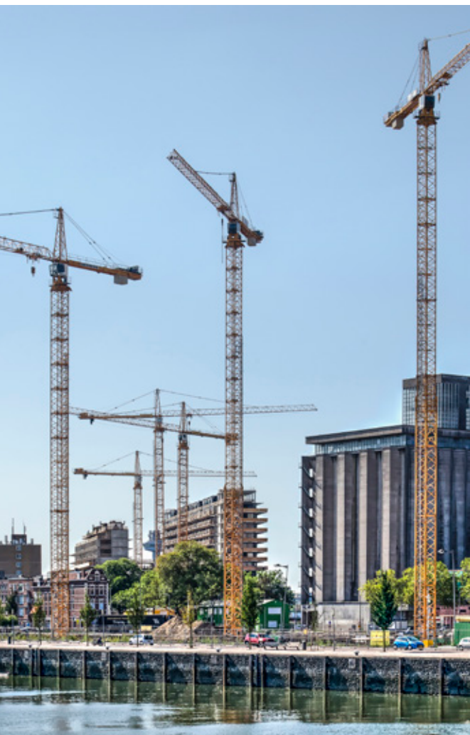
De bouw van een project in de wijk Katendrecht, Rotterdam-Zuid.
